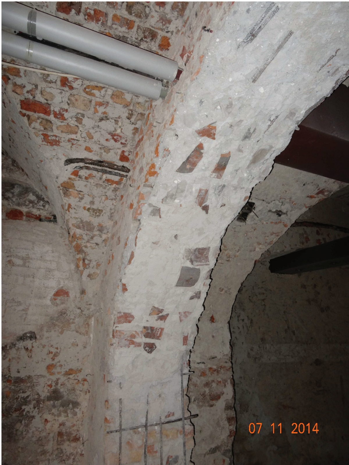
Fot. 11 Słup przyścienny po stronie północnej w trakcie prac modernizacyjnych – widoczne zbrojenie z prętów żebrowanych (źródło: ZKP)
