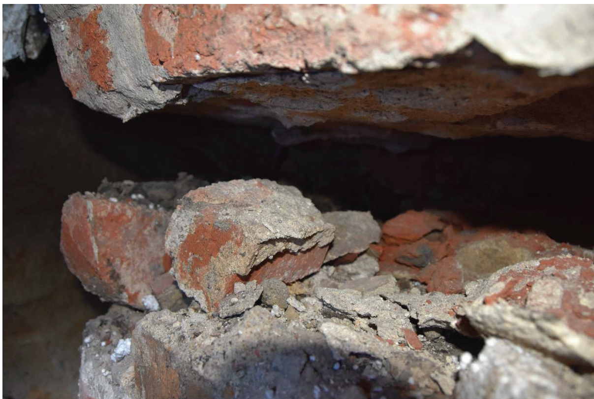
Fot. 15 Szczelina (5-18cm) pomiędzy trzonem słupa i głowicą – narożnik południowo-wschodni. Głowica wsparta na gruncie po stronie południowej i północnej. Stan na dzień 2.02.20019 r.
