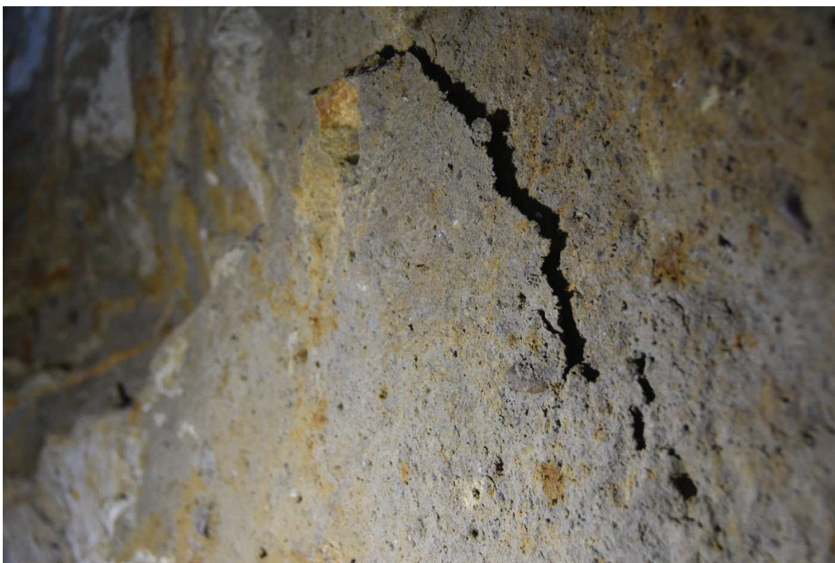
Fot. 27 W ścianie komory widoczne odspojone łuskowe bryły gruntu spoistego. Stan na dzień 2.02.20019 r.
