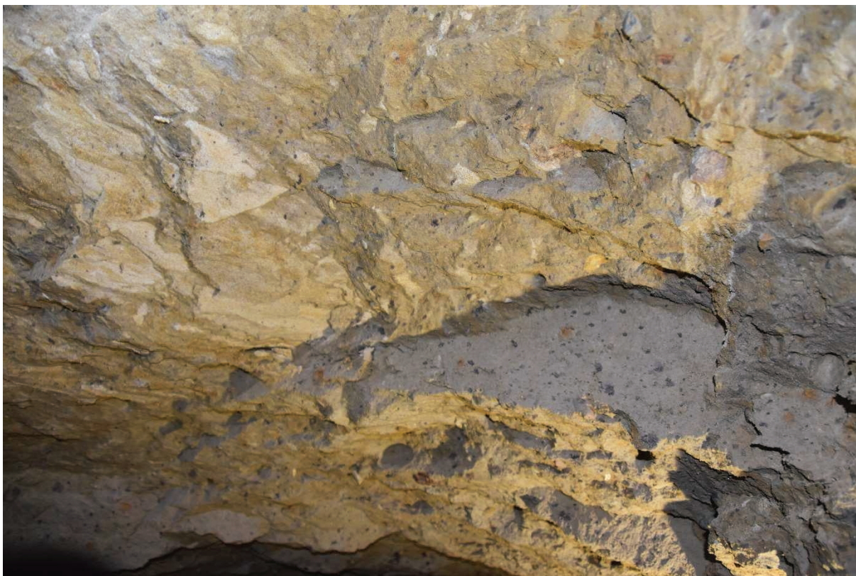
Fot. 26 W ścianie komory widoczne soczewki wypełnione piaskiem i ślady (łuskowe) po odspojeniu odpadających brył gruntu spoistego. Stan na dzień 2.02.20019 r.
