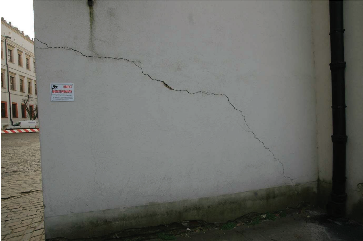
Fot. 38 Fragment ściany przy bramie na Dziedziniec mały od strony tarasu północnego. Pęknięcie o ukośnym przebiegu
