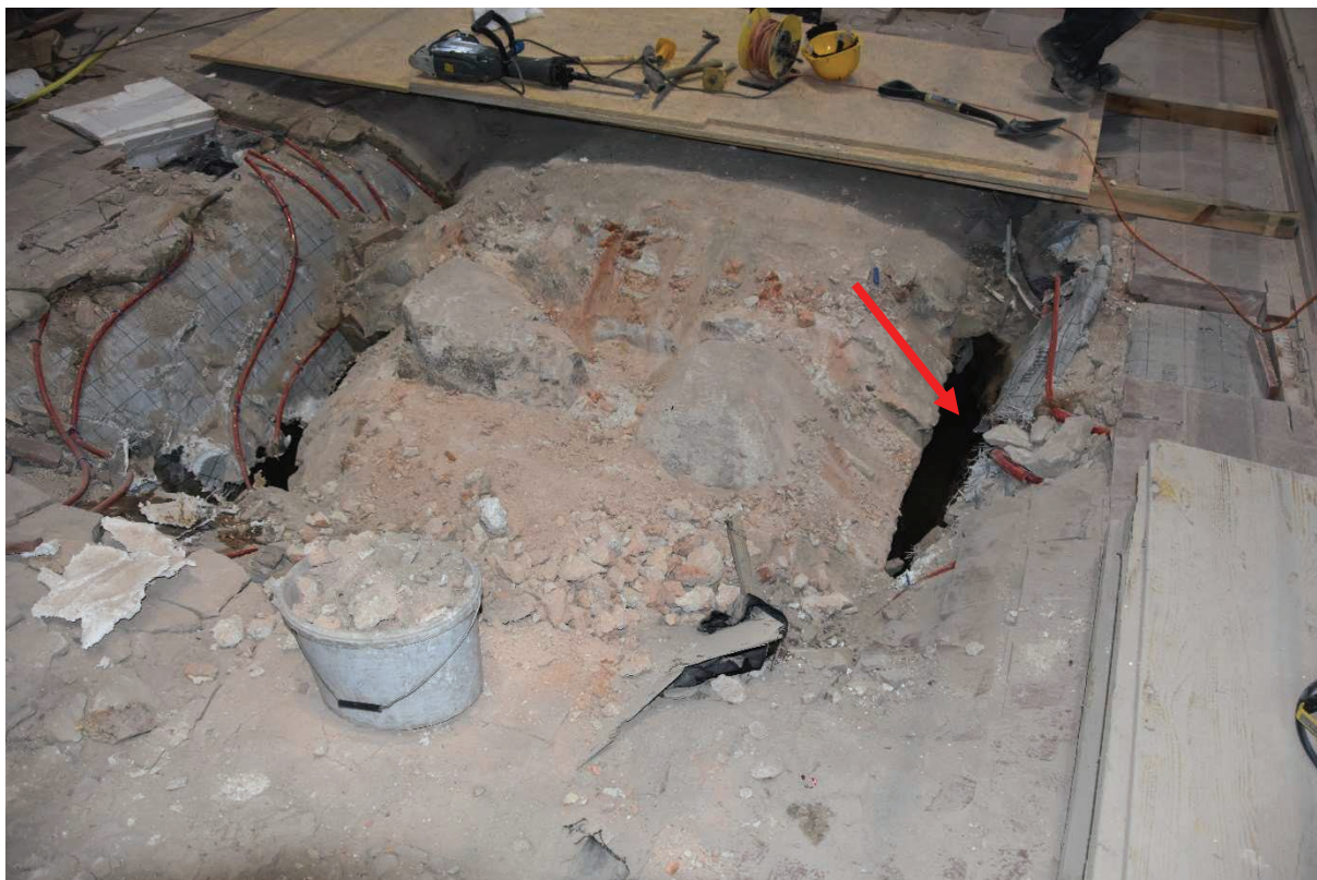
Fot. 14 Szczelina pomiędzy głowicą słupa a posadzką w piwnicy. Widoczna pustka pomiędzy słupem a gruntem. Głowica wsparta na posadzce po stronie południowej i północnej. Stan na dzień 1.02.20019 r.
