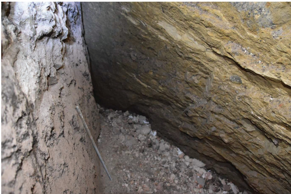
Fot. 28 Widok wzdłuż zachodniego boku słupa od narożnika północno-zachodniego do południowo-zachodniego.. Podłoże ze spadkiem w kierunku północnym. W narożniku południowo-zachodniego nr 2 zachowany reper RPP02. W ściany zapadliska. Widoczne spękania gruntu spoistego. Stan na dzień 2.02.20019 r.
