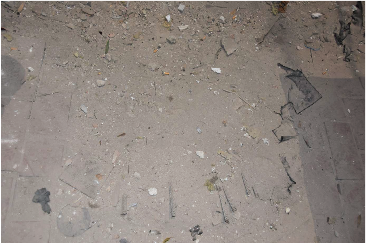
Fot. 5 Fragmenty łuku - pomiędzy słupem piwnicznego i ścianą północną - zawieszony na posadzce piwnicy, widoczne 4 pręty żebrowane będące wzmocnieniem konstrukcji murowej wykonanej przed 2012 r. Stan na dzień 1.02.20019 r.
