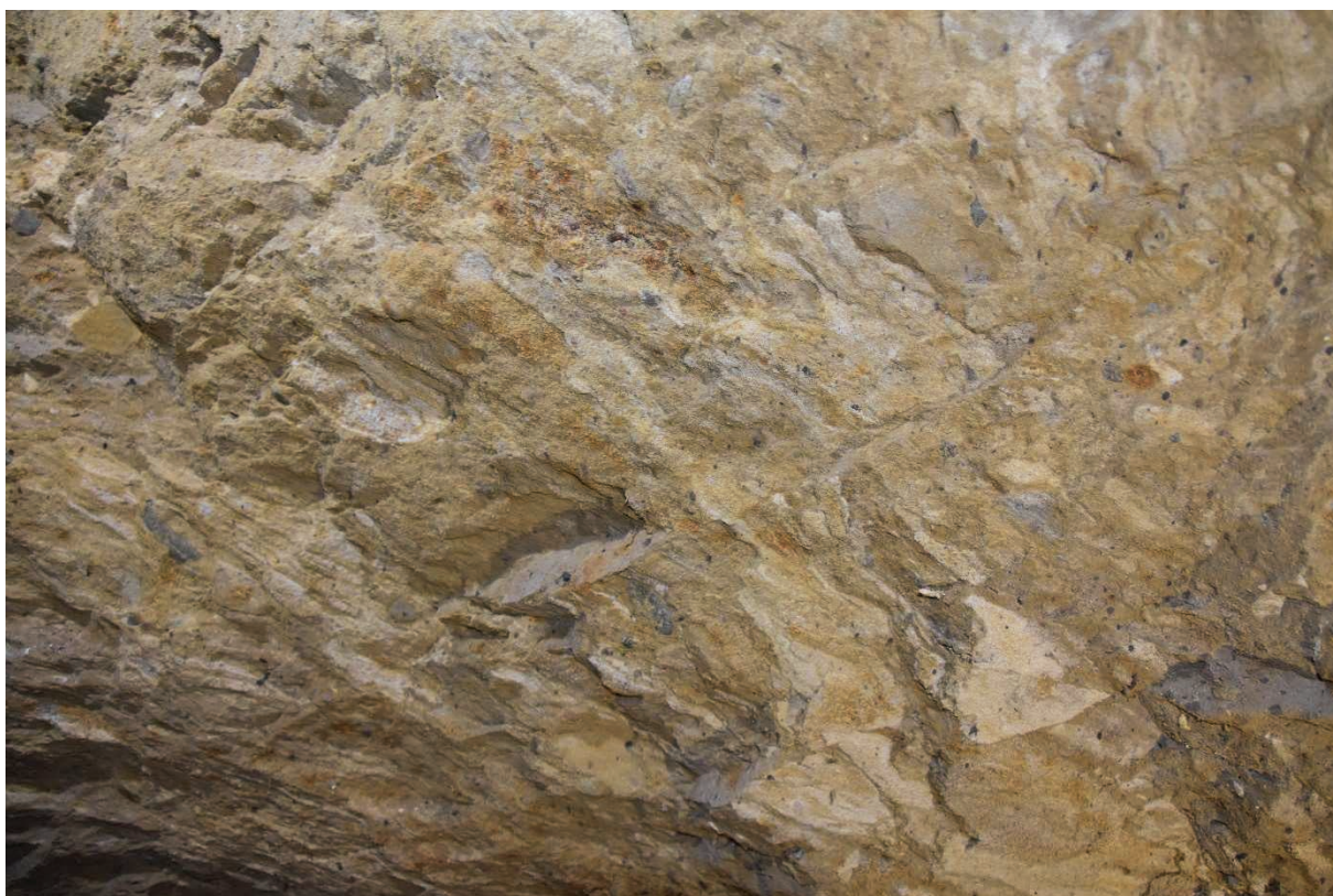
Fot. 25 W ścianie komory widoczne spękania gruntu spoistego wypełnione piaskiem, i ślady (łuskowe) po odspojeniu odpadających brył gruntu. Stan na dzień 2.02.20019 r.
