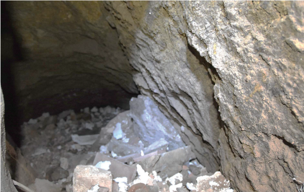
Fot. 22 Widok wzdłuż północnego boku słupa od filara przystupowego do narożnika północno-zachodniego „sklepienie” zapadliska, sięgającego poniżej poziomu gruntu przy filarze Stan na dzień 2.02.20019 r.
