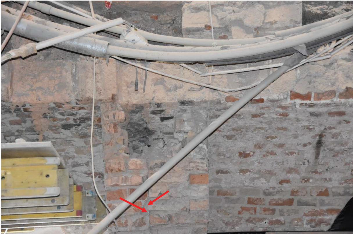
Fot. 7 Fragment filara przyściennego (ściana północna) oraz fragment łuku. pręty żebrowane wzmacniające konstrukcję murową, struktura łuku niejednorodna, ślady po przeprowadzonej w przeszłości przebudowie, dylatacja, brak przewiązania
