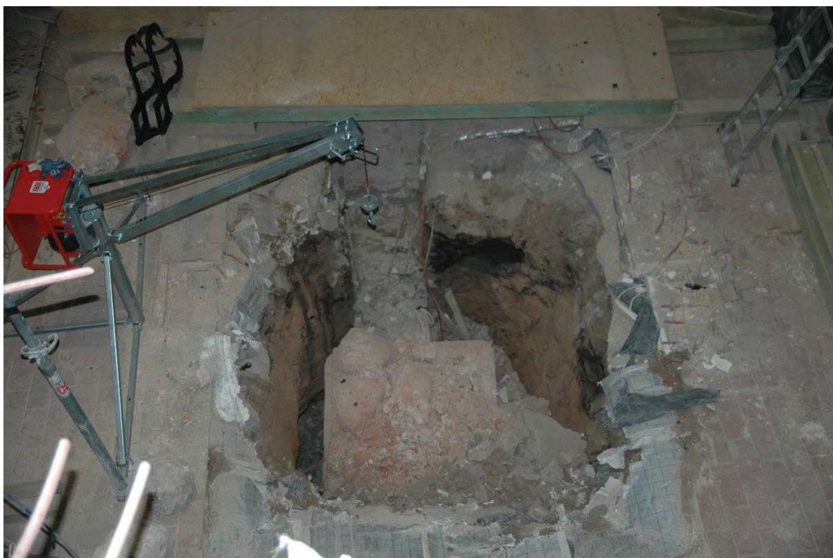
Fot. 31 Słup w trakcie prac rozbiórkowych. Stan na dzień 28.02.20019 r.
