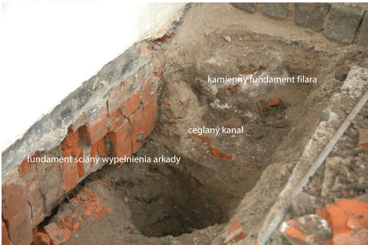
Fot. 41 Odkrywka fundamentu. Stan na dzień 28.02.20019 r.
