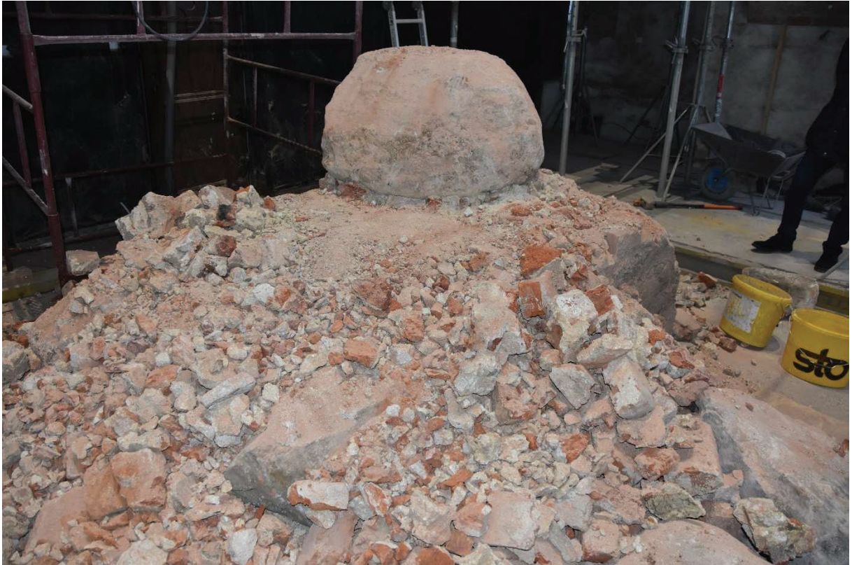
Fot. 12 Słup w trakcie rozbiórki. Kamienie o masie do 1,2 t.
