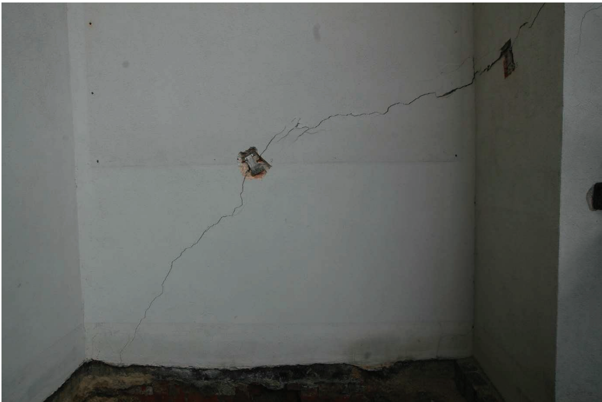
Fot. 39 Fragment ściany przy bramie na Dziedziniec mały od strony tarasu północnego. Na pęknięciu o ukośnym przebiegu założone wskaźniki rozwarcia rys po 11.05.2017 r.
