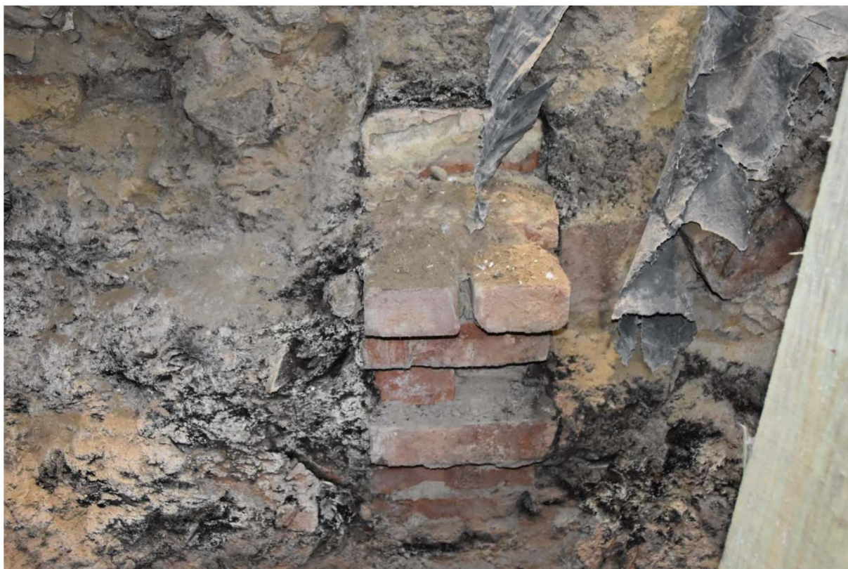
Fot. 19 Wschodnia ściana zapadliska. W warstwie nasypowej fragmenty muru z czasów fundowania zamku [24]. Stan na dzień 2.02.20019 r.
