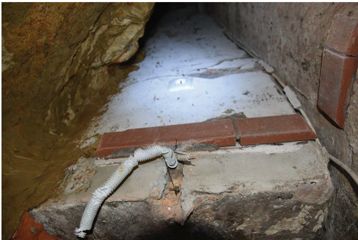
Fot. 30 Filar przysłupowy od strony zachodniej. Brak dolnego fragmentu filara. Zachowane płytki cokolika przypodłogowego. Filar w dolnej części odspojony trzonu słupa. Stan na dzień 2.02.20019 r.
