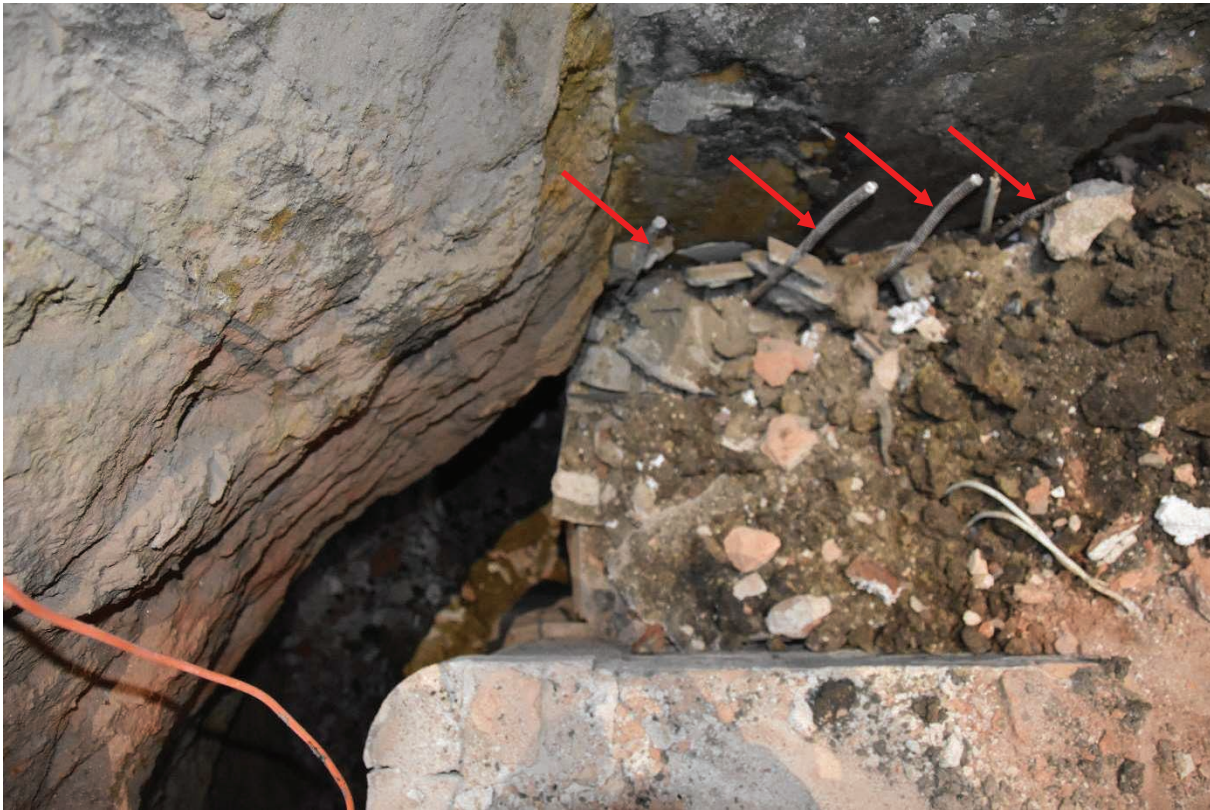
Fot. 32 Fragment słupa w trakcie prac rozbiórkowych. Widoczne pręty wzmocnienia filara przyściennego. Od strony gruntu pręty wzmocnienia filara przysłupowego Stan na dzień 4.03.20019 r.
