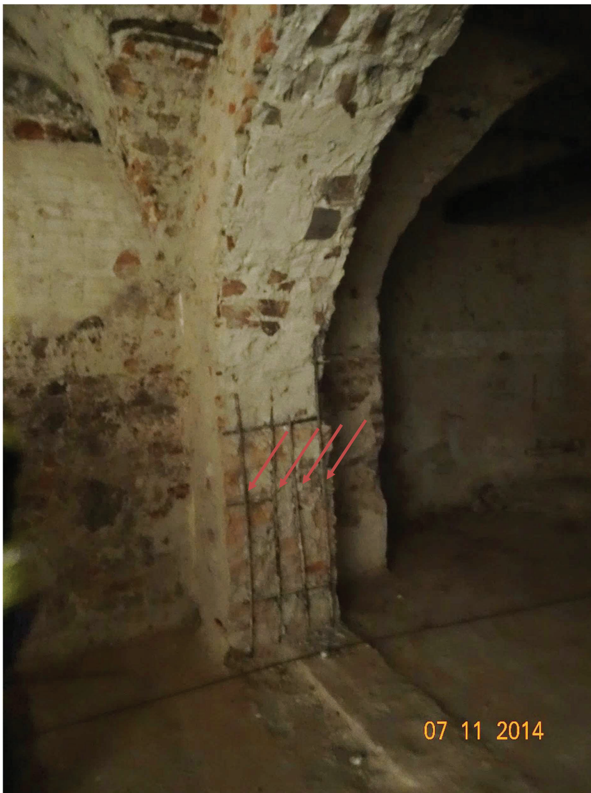
Fot. 9 Słup przyścienny po stronie północnej w trakcie prac modernizacyjnych – widoczne zbrojenie z prętów żebrowanych (źródło: ZKP)
