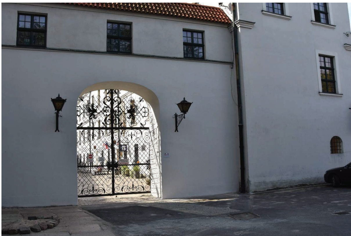
Fot. 43 Ściana po pracach remontowych od strony północnej. Stan na dzień 4.09.2009 r.
