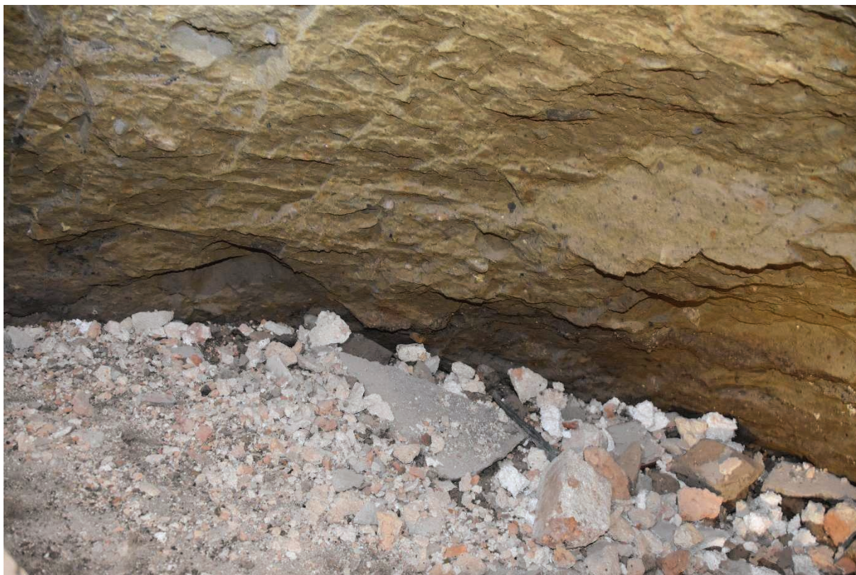
Fot. 24 Komora zapadliska w ścianie zapadliska, widoczne ukośne szczeliny w gruncie spoistym, wypełnione piaskiem. Widoczne ślady odpływu wody w kierunku północno-zachodnim. Stan na dzień 2.02.20019 r.
