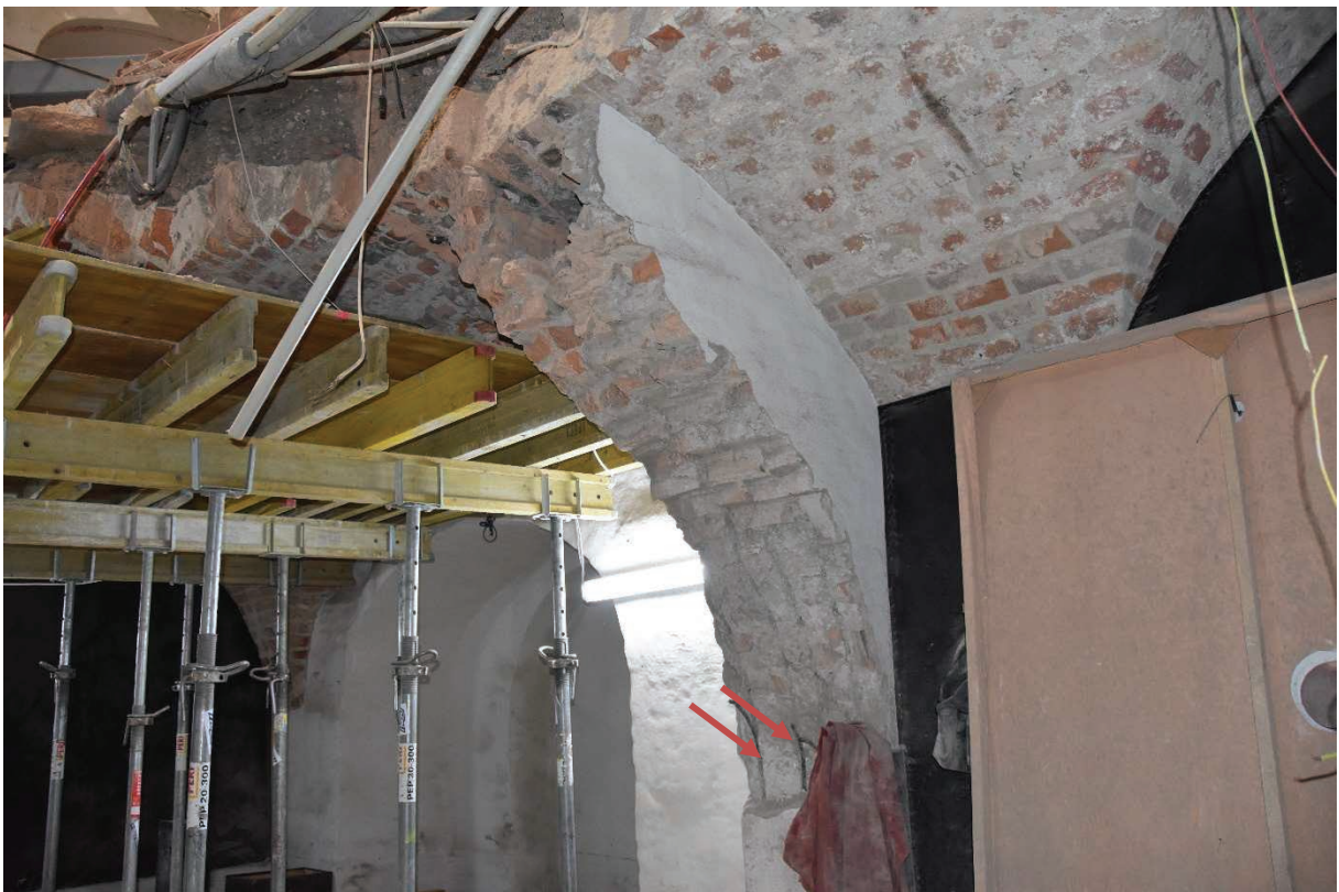
Fot. 6 Fragment filara przyściennego (ściana północna) oraz fragment łuku. pręty żebrowane wzmacniające konstrukcję murową, struktura łuku niejednorodna
