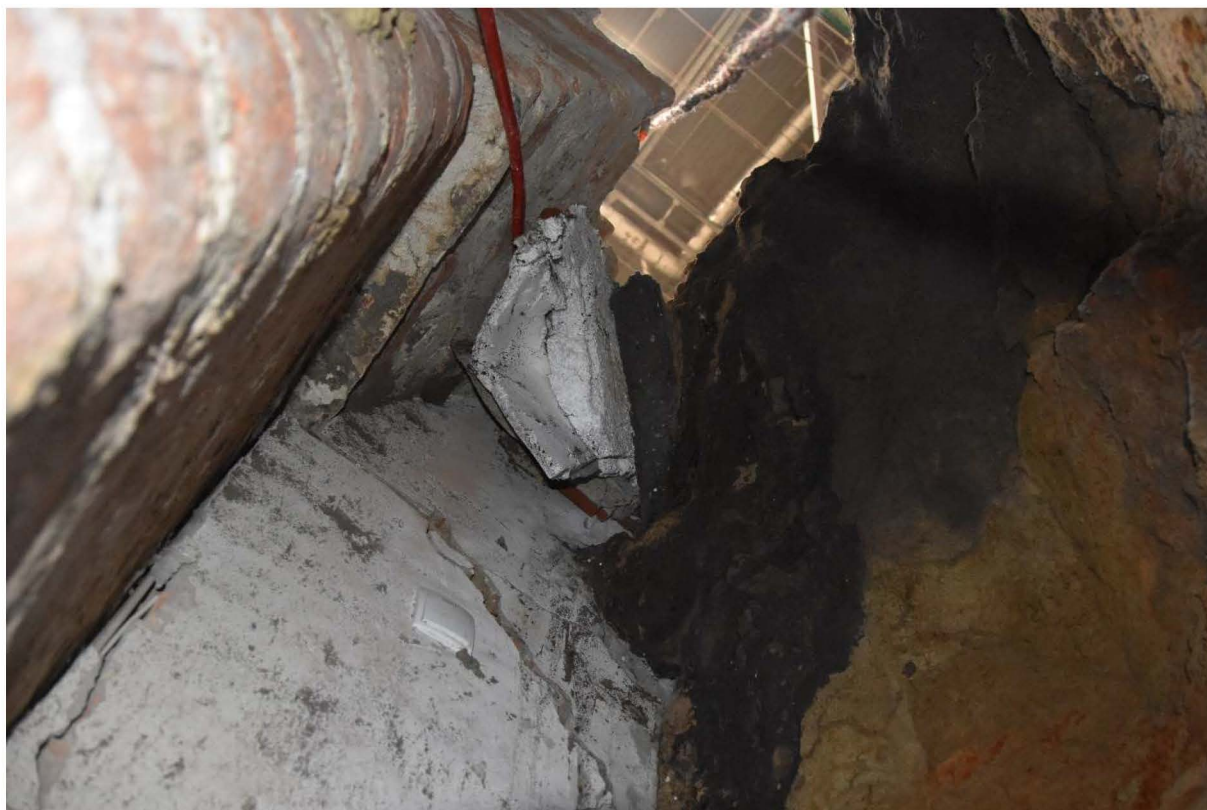
Fot. 21 Widok wzdłuż północnego boku słupa od narożnika północno-wschodniego do filara przysłupowego. Filar spękany przylega do gruntu (na krawędzi zabrudzenia od piasków gliniastych). Stan na dzień 2.02.20019 r.
