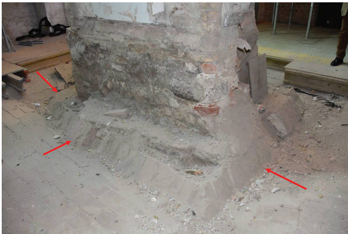
Fot. 3 Fragment słupa – pierwotnie z poziomu parteru, posadzka ze spadkiem w kierunku słupa. Stan na dzień 17.10.2008 r.
