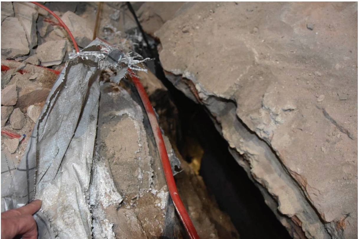
Fot. 13 Szczelina pomiędzy głowicą słupa a posadzką w piwnicy. Widoczna pustka pomiędzy słupem a gruntem. Stan na dzień 31.01.20019 r.
