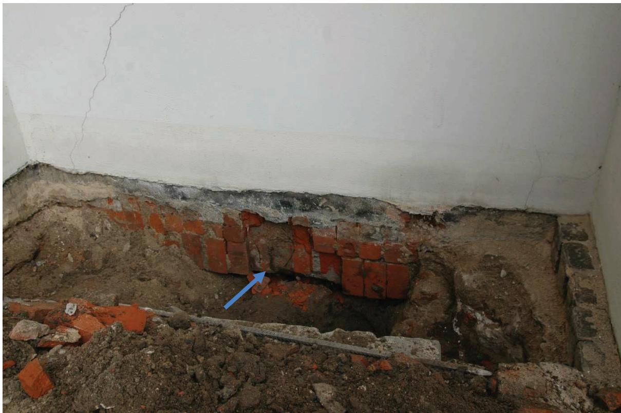
Fot. 40 Odkrywka fundamentu. Pustka pod fundamentem Stan na dzień 28.02.20019 r.
