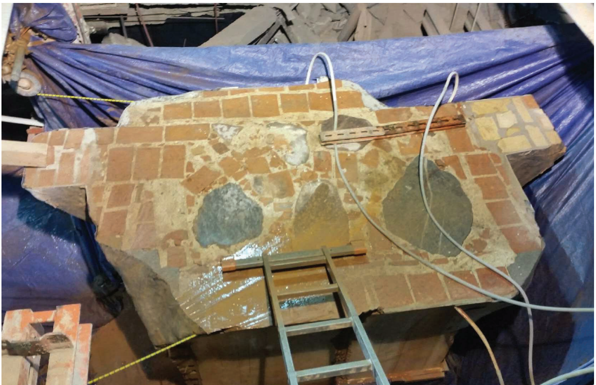
Fot. 2 Przekrój poziomy – konstrukcja kamienno-ceglana
