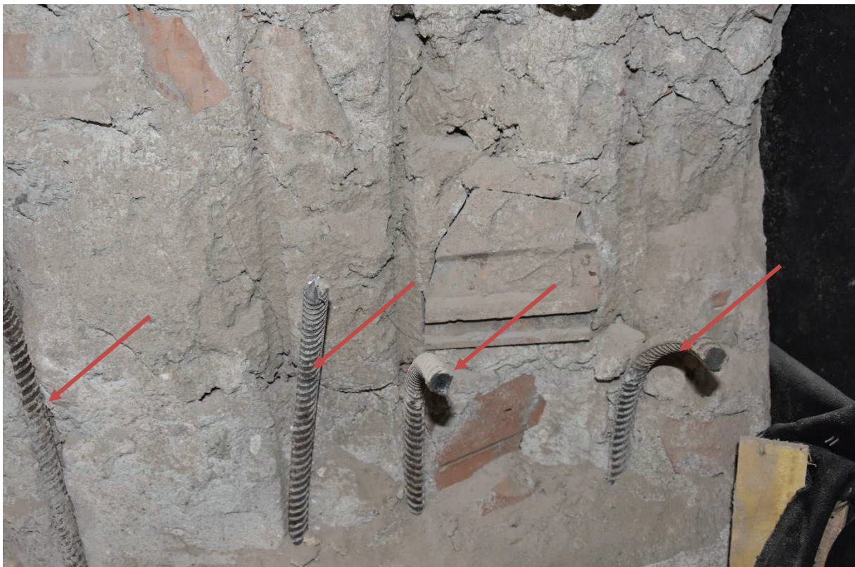
Fot. 8 Fragment łuku. pręty żebrowane wzmacniające konstrukcję murową,
