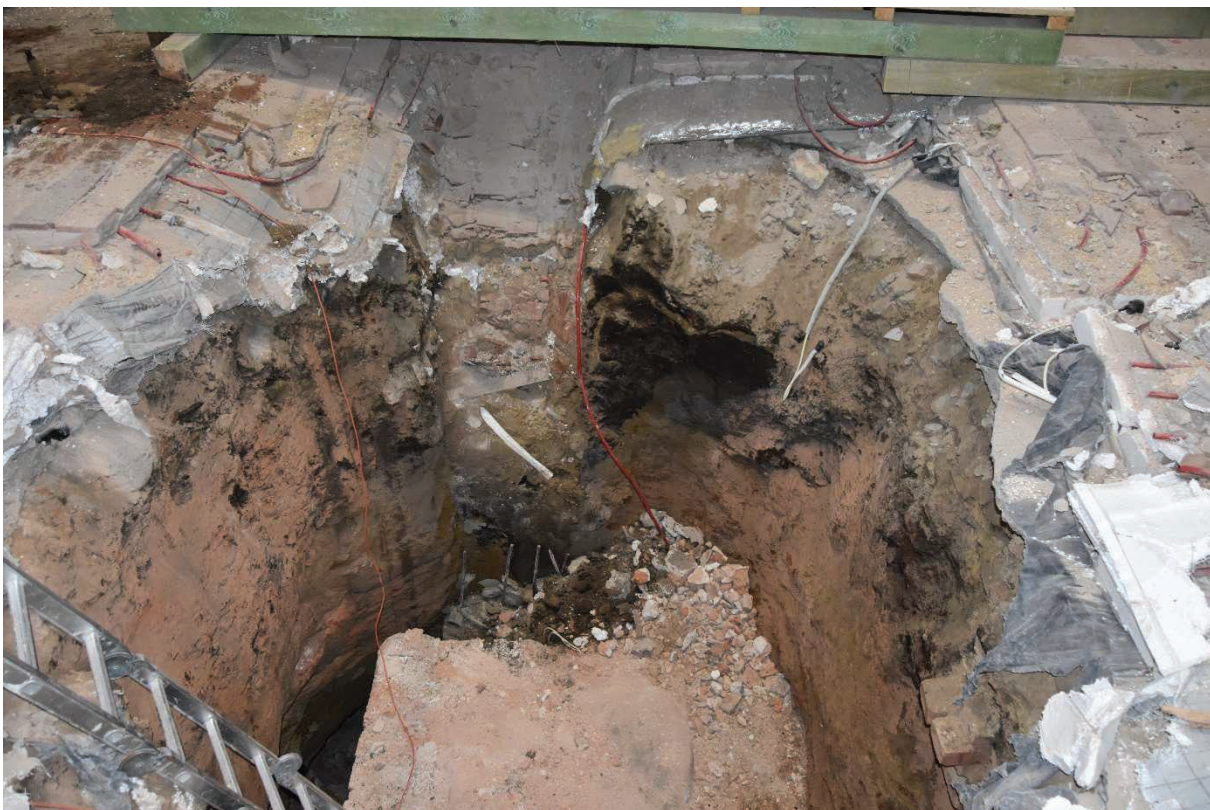
Fot. 33 Fragment słupa w trakcie prac rozbiórkowych. Widoczne pręty wzmocnienia filara przyściennego. Stan na dzień 4.03.20019 r.
