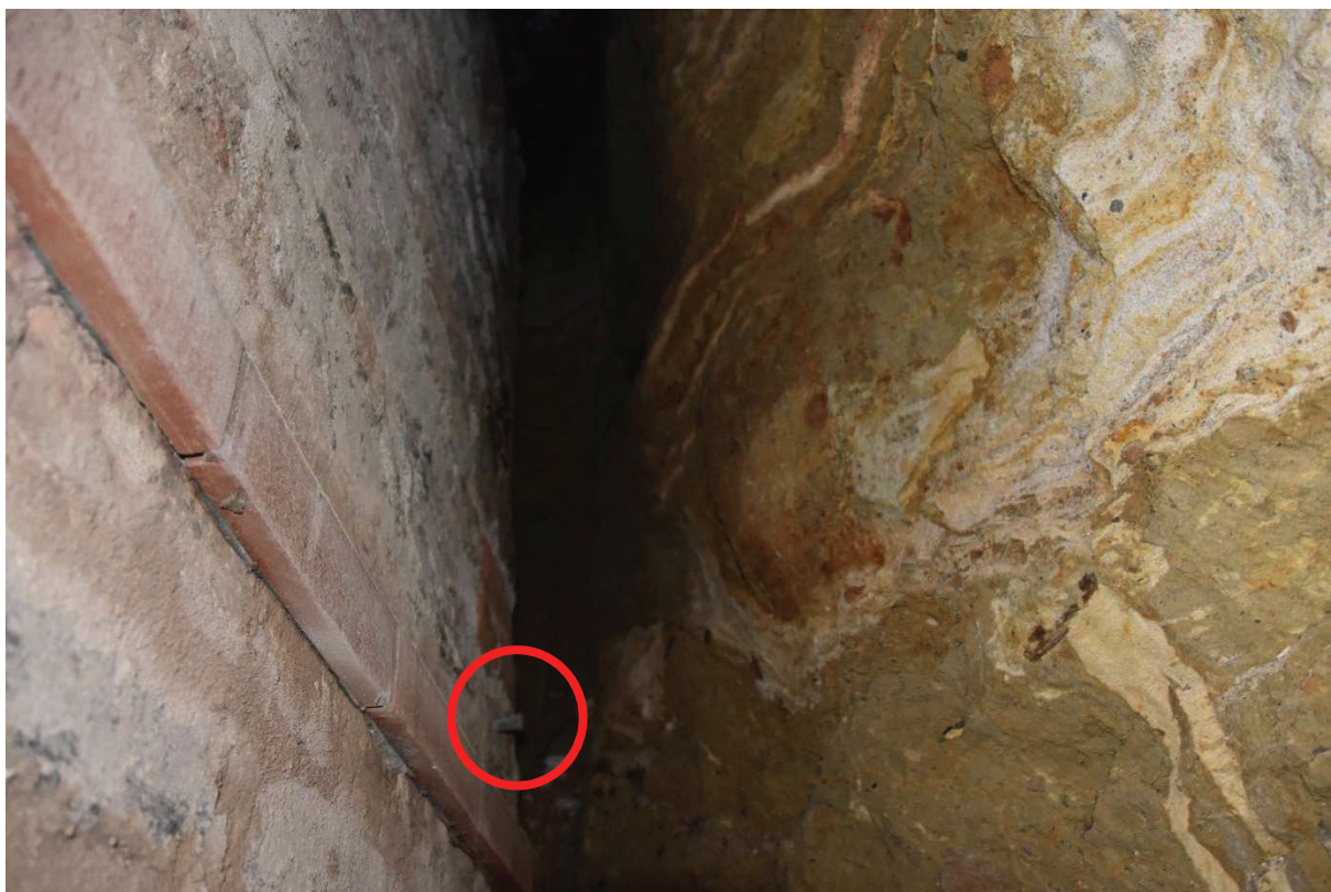
Fot. 29 Widok wzdłuż zachodniego boku słupa od narożnika północno-zachodniego do południowo-zachodniego W narożniku południowo-zachodnim nr 4 zachowany reper RPP02. Widoczne spękania gruntu spoistego. Stan na dzień 2.02.20019 r.
