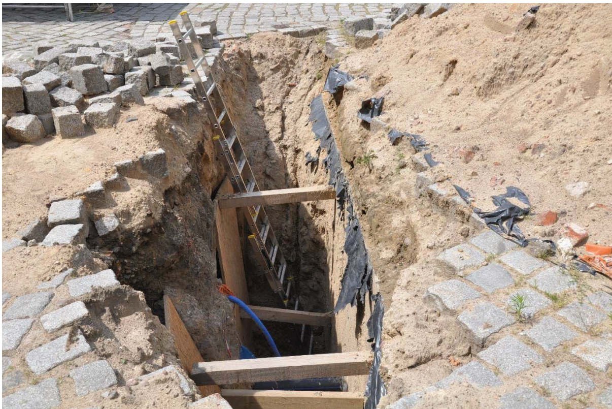
Fot. 44 Odkrywka ściany południowej zbiornika. Stan na dzień 2.04.2019 r.
