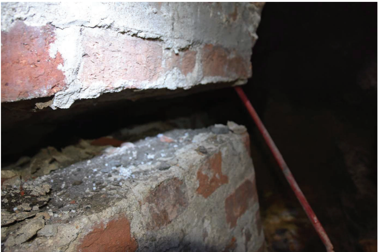
Fot. 17 Szczelina pomiędzy trzonem słupa i głowicą w narożniku północno-wschodnim. Stan na dzień 2.02.20019 r.
