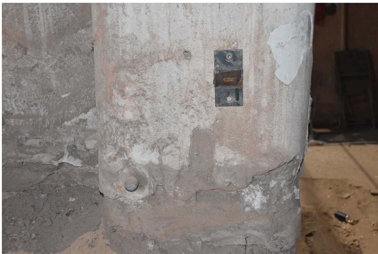
Fot. 4 Fragment słupa od strony południowej. Na trzonie reper RPP2. Stan na dzień 31.01.2009 r.
