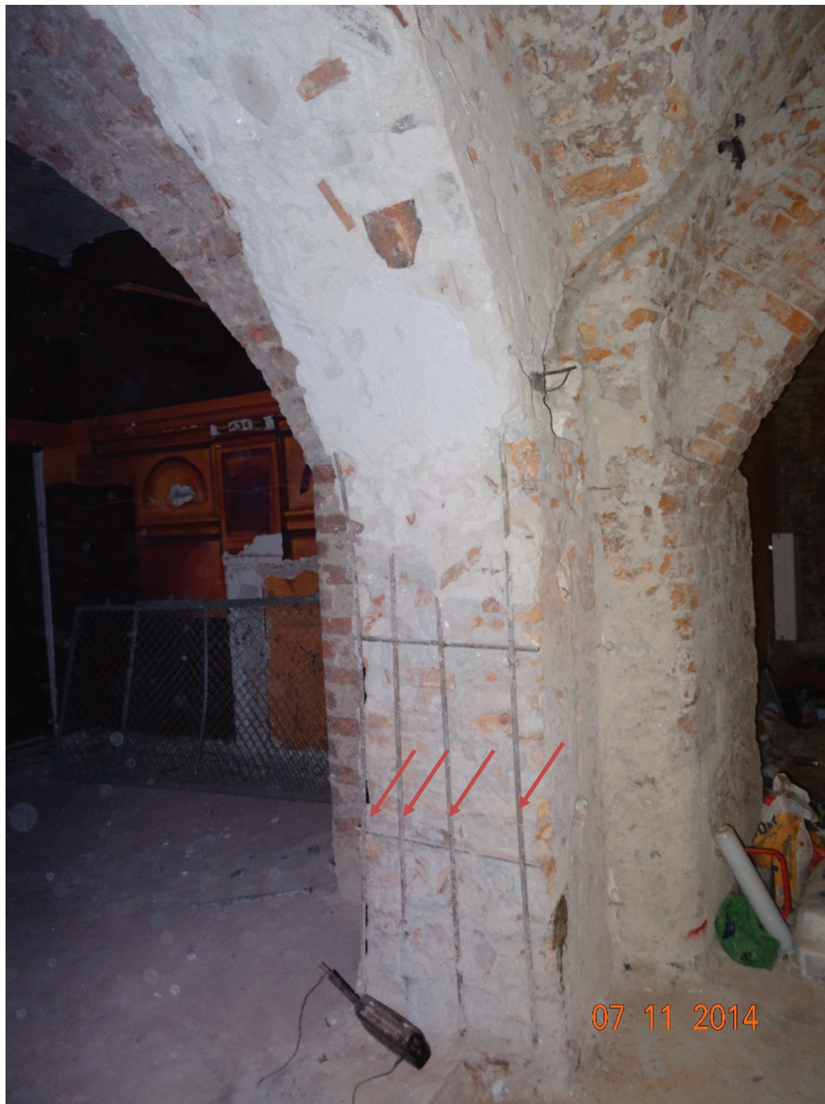
Fot. 10 Słup przyścienny po stronie północnej w trakcie prac modernizacyjnych – widoczne zbrojenie z prętów żebrowanych (źródło: ZKP)
