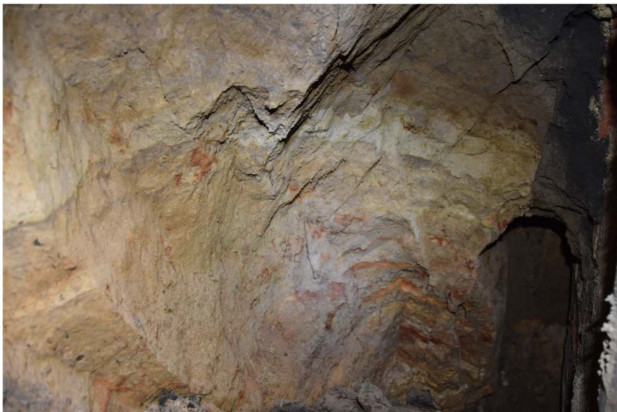
Fot. 18 Widok wzdłuż południowego boku słupa od narożnika południowo-wschodniego do południowo-zachodniego. W połowie szerokości słupa gwałtowne obniżenie podłoża. Przy narożniku południowo-zachodnim wysklepiona ku górze nisza. Stan na dzień 2.02.20019 r.
