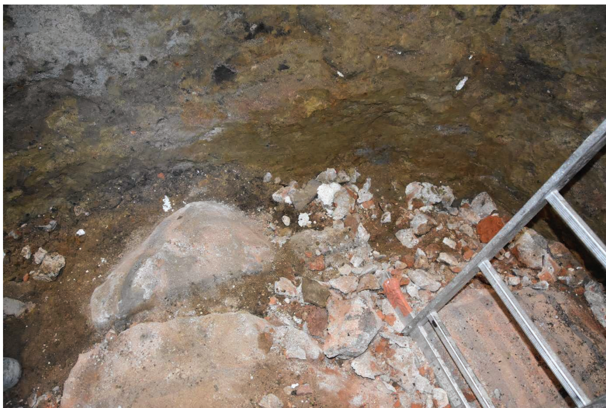
Fot. 35 Fragment słupa w trakcie prac rozbiórkowych. Otoczaki w stopie fundamentowej. Stan na dzień 13.03.20019 r.
