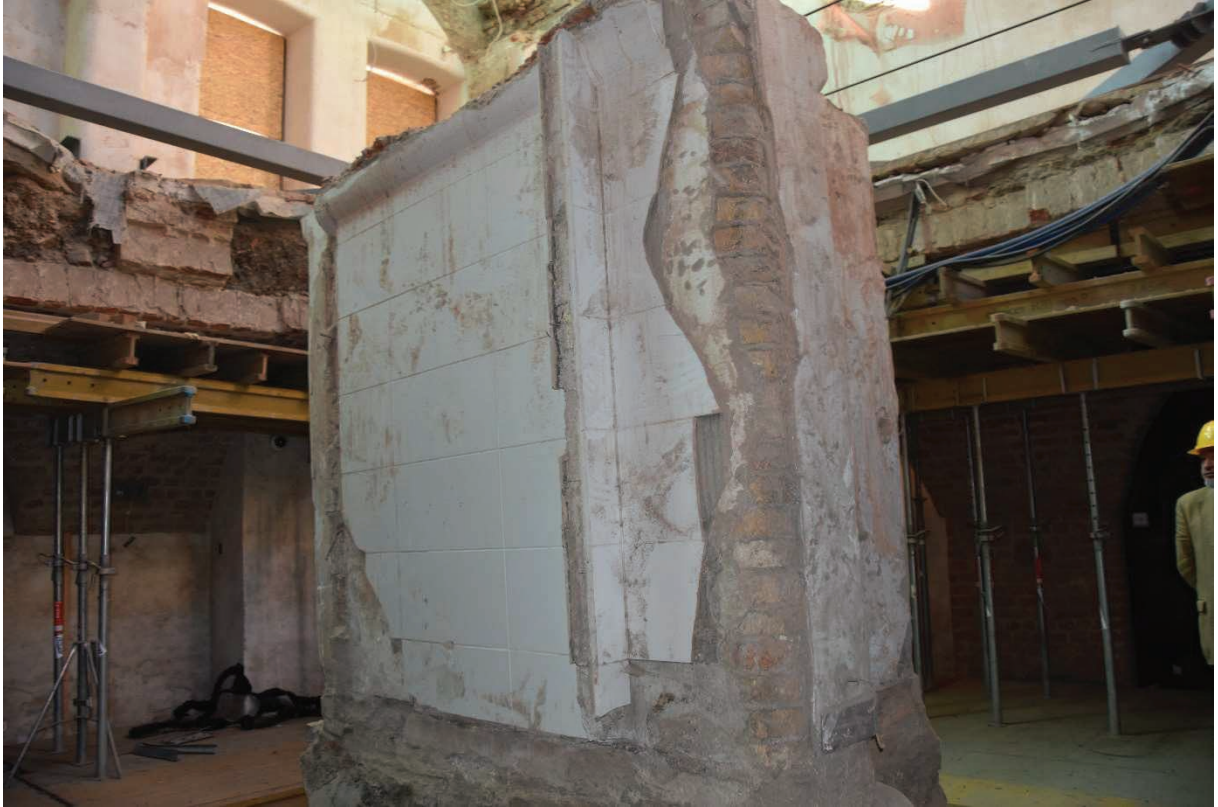
Fot. 1 Słup z poziomu parteru po przemieszczeniu - w wyniku katastrofy – na poziom piwnicy. Stan na dzień 17.10.20018 r.
