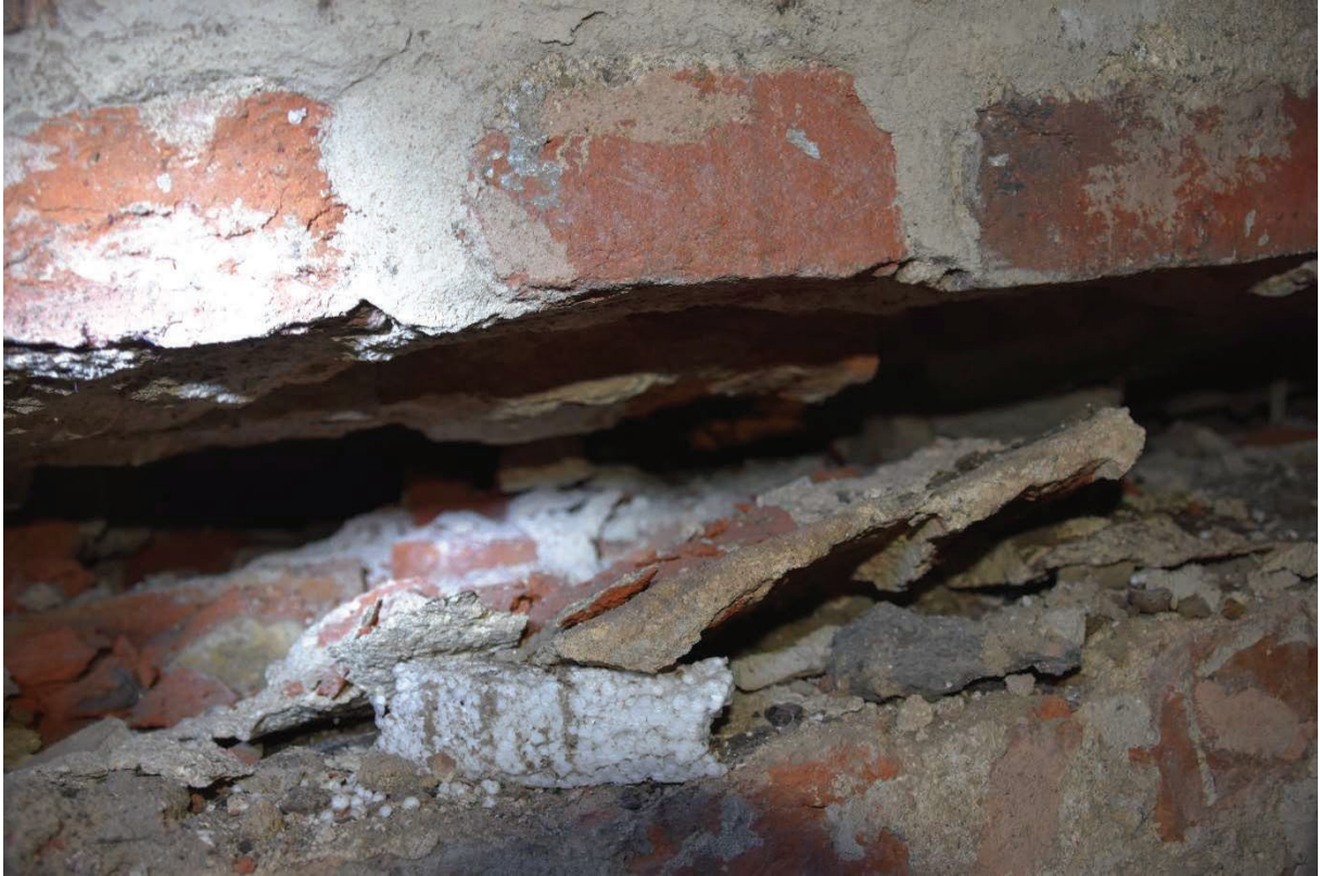
Fot. 16 Szczelina pomiędzy trzonem słupa i głowicą. W szczelinie fragmenty styropianu, blaszkowate fragmenty cegły i zaprawy. Stan na dzień 2.02.20019 r.
