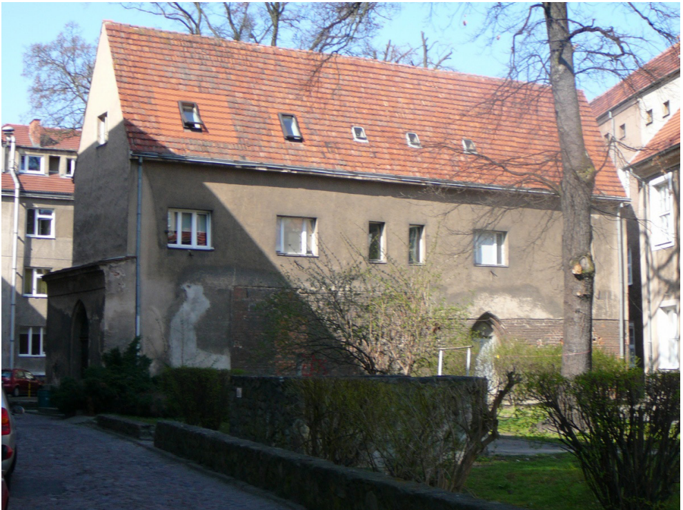
Il. 12. Zaulek Mariacki w Szczecinie, w dolnej części budynku widoczny ceglany fragment ściany z ostrołukiem – pozostałość po dawnym budynku Pedagogium. Źródło: pomeranica.pl
