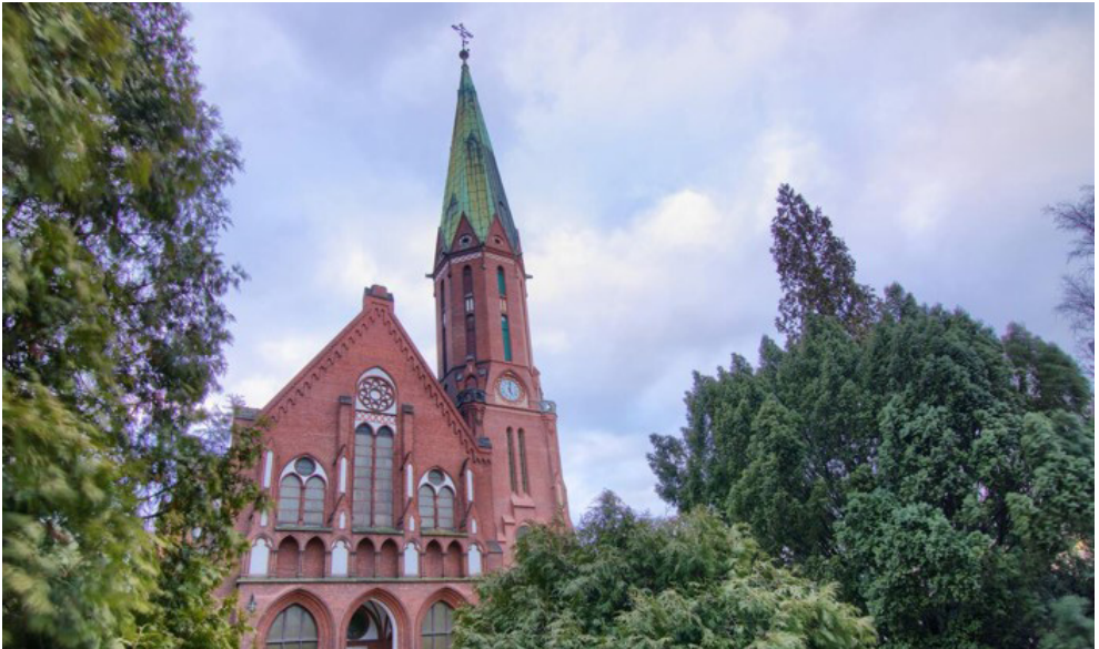
Il. 19. Kościół ewangelicko-augsburski Świętej Trójcy w Szczecinie przy ul. Energetyków 8. Źródło: PEA w Szczecinie
